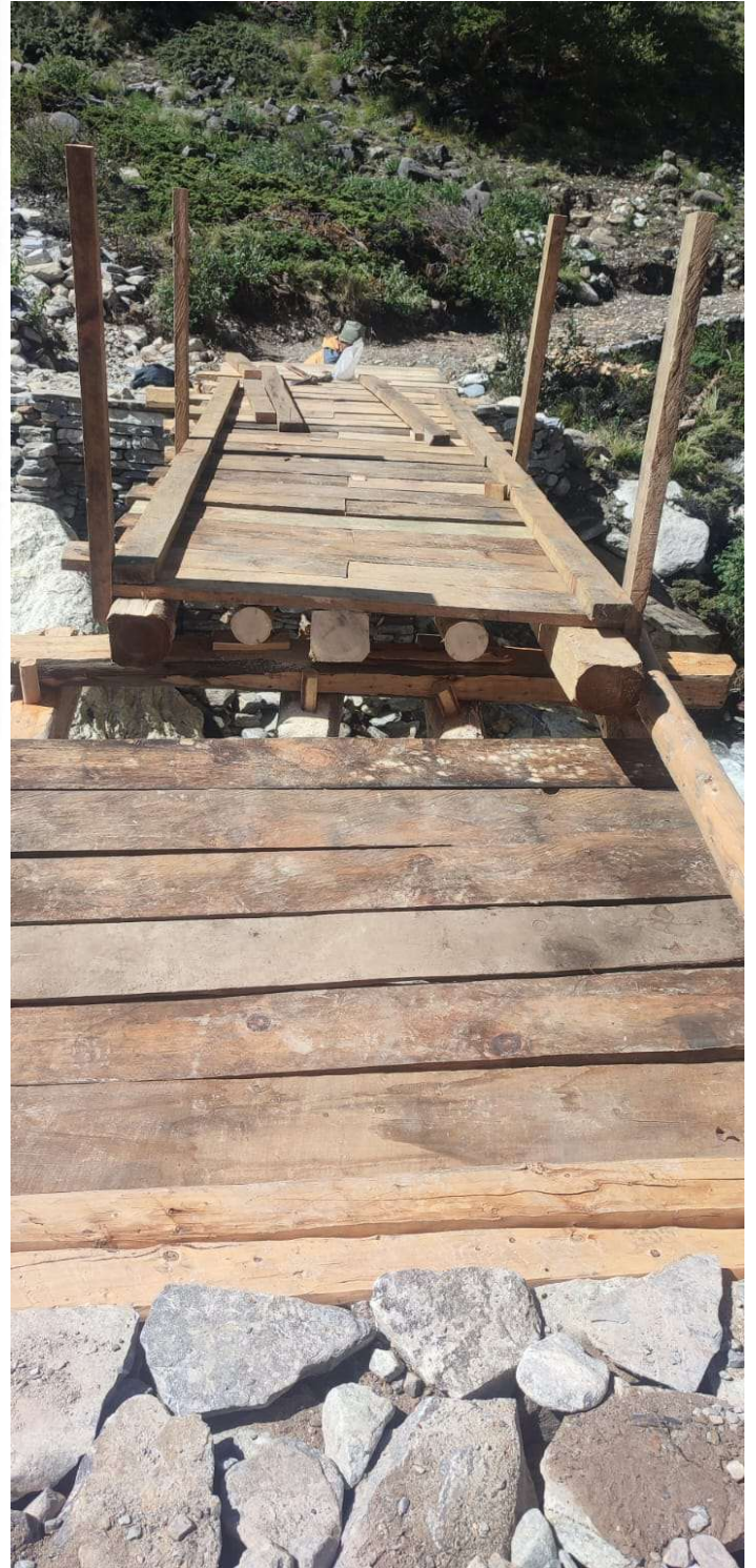
खेवे खोलामा काठे पुल निर्माण
