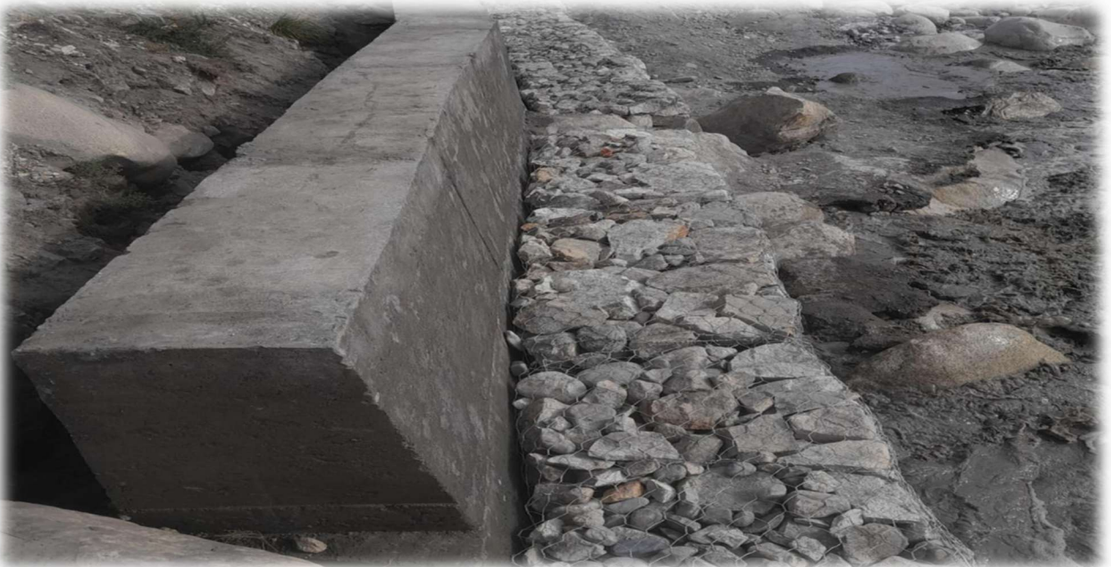
वागल खोलामा RCC तटबन्धन, फू गाउँ
