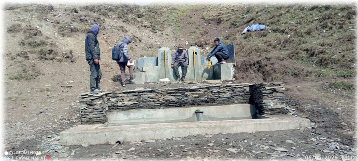
क्याङ खानेपानि निर्माण
